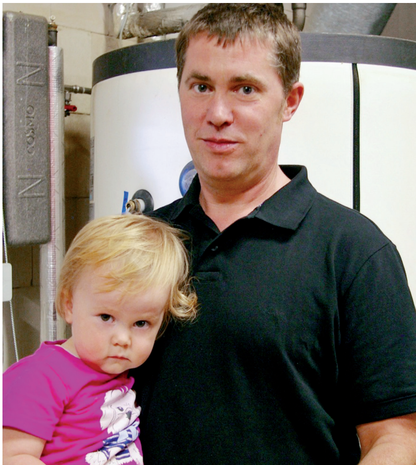
Frank Feldmann und sein Nachwuchs nutzen die Wärme des BHKWs unter anderem für die Hackschnitzel-Anlage.
